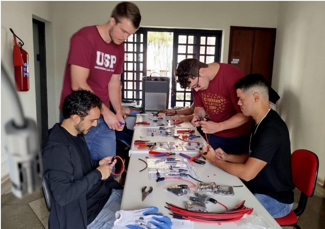
Oficina de ligação de montagem da String-box e o Inversor Fotovoltaico
